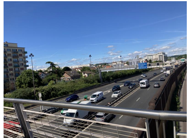
Vue sur l'A86 depuis la Place de la Bièvre – INGEROP 2022
