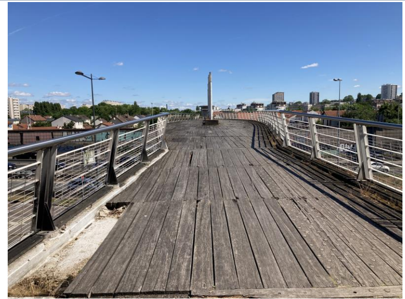
Passerelle de l'A86, Place de la Bièvre – INGEROP 2022)
