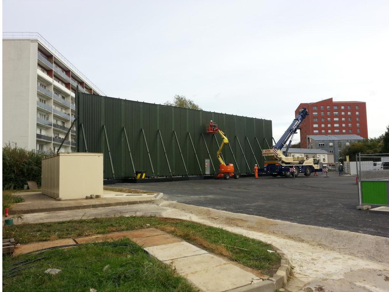
*Illustrations de la mise en place de murs anti-bruit lors d'un forage à Ris-Orangis*
