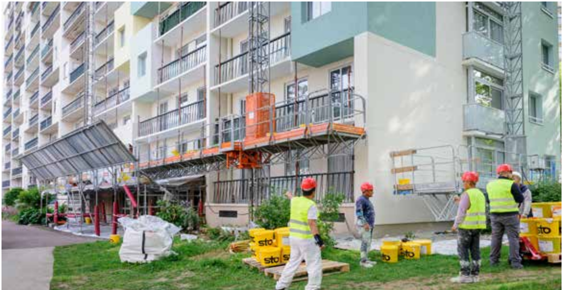
La rénovation thermique des bâtiments, un impératif dans de nombreuses situations (94) © Terra/MTE
