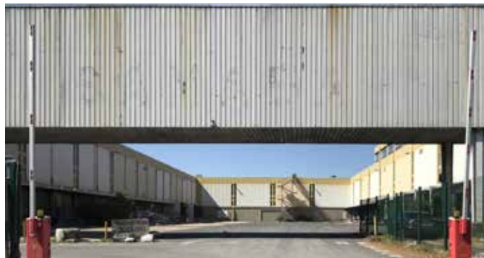
site désaffecté Sénia à Orly et Thiais, projet en cours (94) © MRAe-Idf
