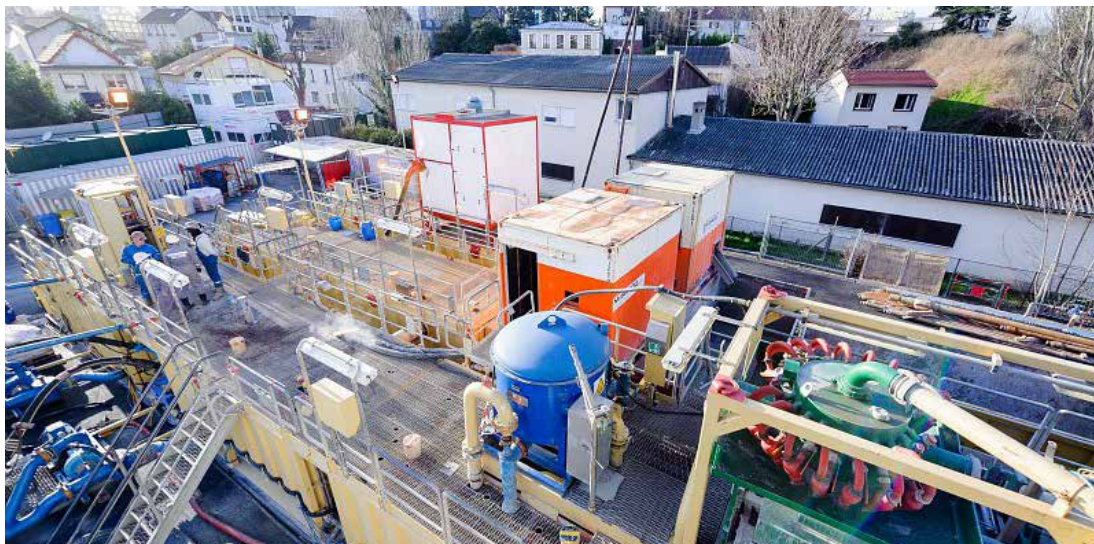
Projet géothermique à Arcueil et Gentilly (94), © Terra/MTE
