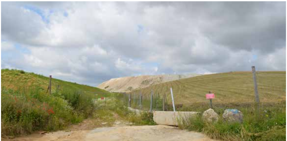
Installation de stockage de déchets non dangereux à Villeneuve-sous-Dammartin (77) © MR Ae-Idf
