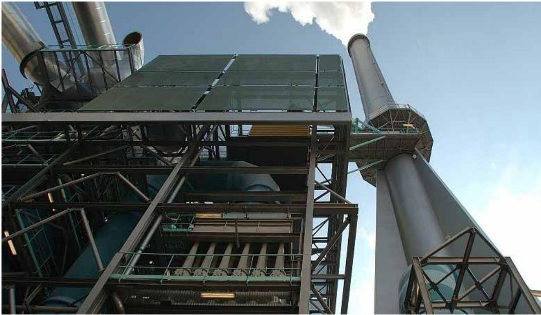
Centre d'incinération à valorisation énergétique à Ivry-sur-Seine (94), © Terra/MTE
