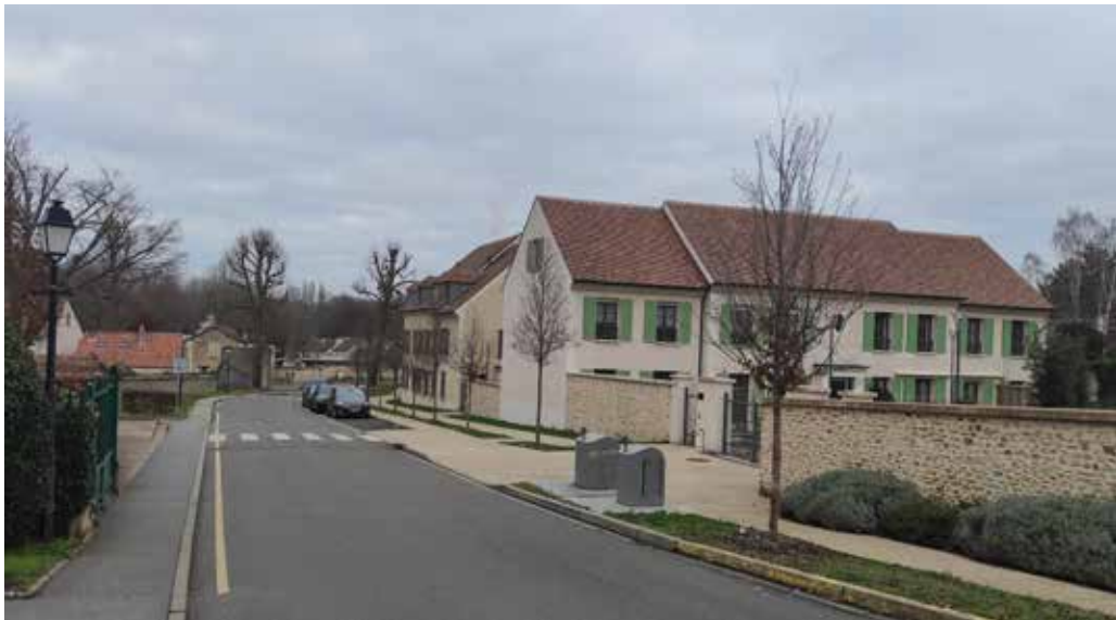
Développements urbains à Montfort Lamaury (78) ©MRAe-IdF
