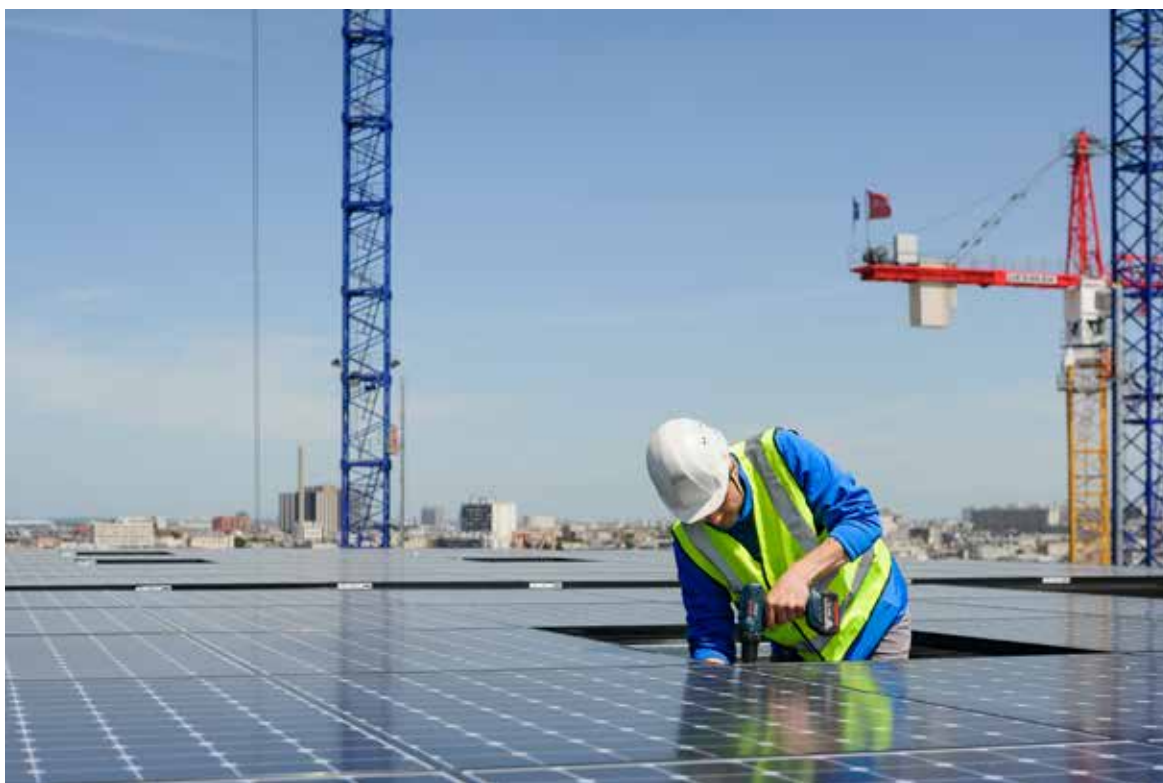
Intervention d'un technicien sur un panneau photovoltaïque sur le chantier de la ZAC Clichy-Batignolles © Terra/MTE
